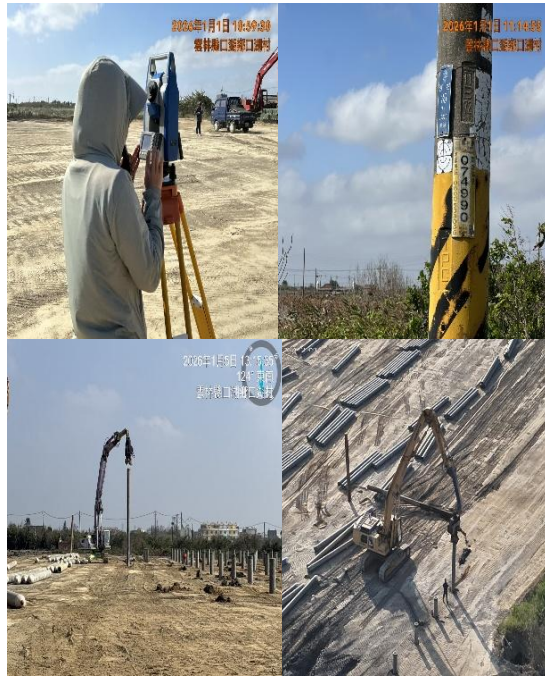
施工作業暨施工中定位確認
