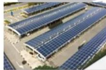
中東最大屋頂電站 杜拜(28MW)
