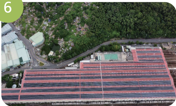
臺鐵 _ 樹林調車場 新北 1,999.8 kWp
