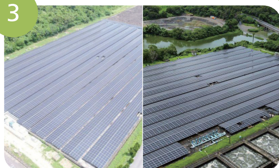
台水七 _ 鳳山東 / 西淨水池 高雄 5,785.92 kWp
